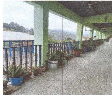
Foto 6: MANTENIMIENTO A BARANDAS
