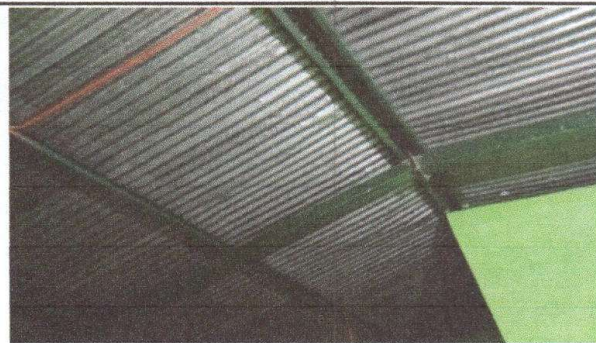
Foto 2: ESTRUCTURA DE TECHO
