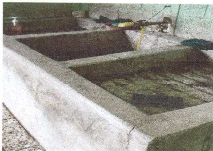
Foto1: Sustitución de pila de cemento de dos lavaderos
