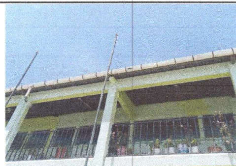
Foto 4: CANALES Y BAJADAS DE AGUA PLUVIAL
